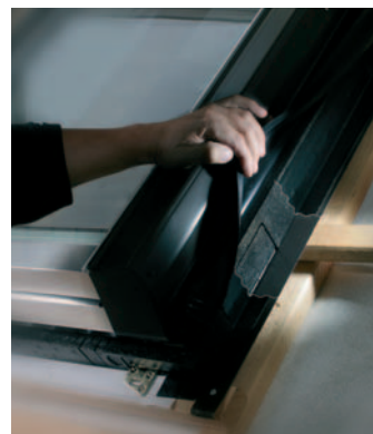
Bei schwer zugänglichen Bereichen sorgt eine vormontierte Wärmedämmung für eine luftdichte Isolierung der Nahtstellen am Fenster.
