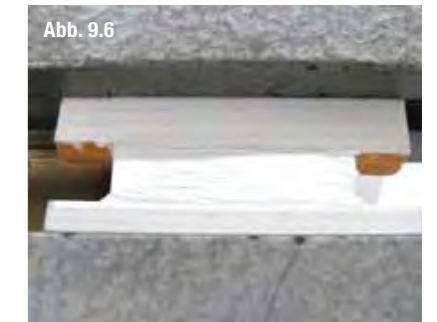
Stauchung des Dichtstoffs mit dem aufgetragenen Beschichtungsfilm
