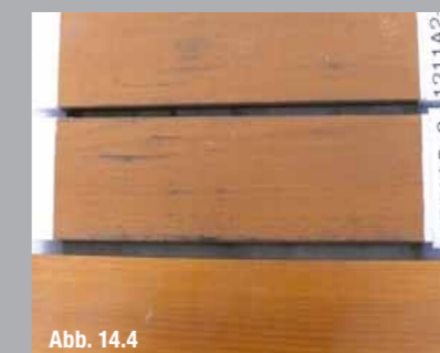
Beschichtung mit 3 Arbeitsgängen Cetol BLX Pro
