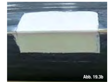
Reparatur von Holzfehlstellen
