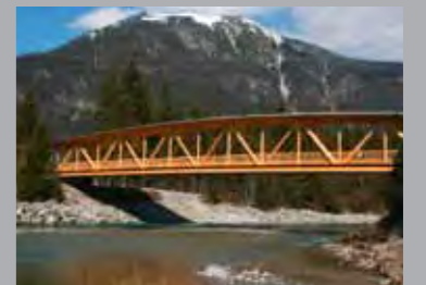
Holzbrücke in Weissenbach (Österreich); eine Konstruktion aus Brett-schichtholz, für die ein physikalischer Oberflächenschutz durch Beschichtung nicht erforderlich ist.
