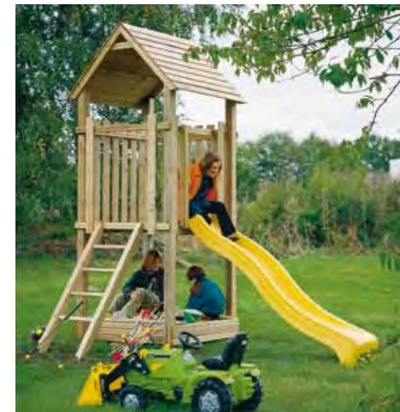
Abb. 4.1: Spielturn: aus druckimprägniertem Kiefernholz. In diesem Fall: nicht maßhaltig.
