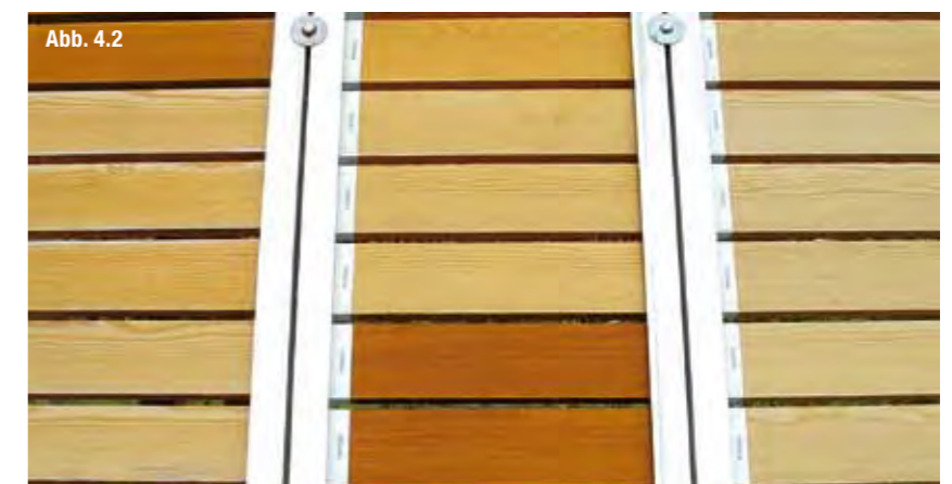
Prüfkörper ohne Wasserfalle in der Freibewitterung
